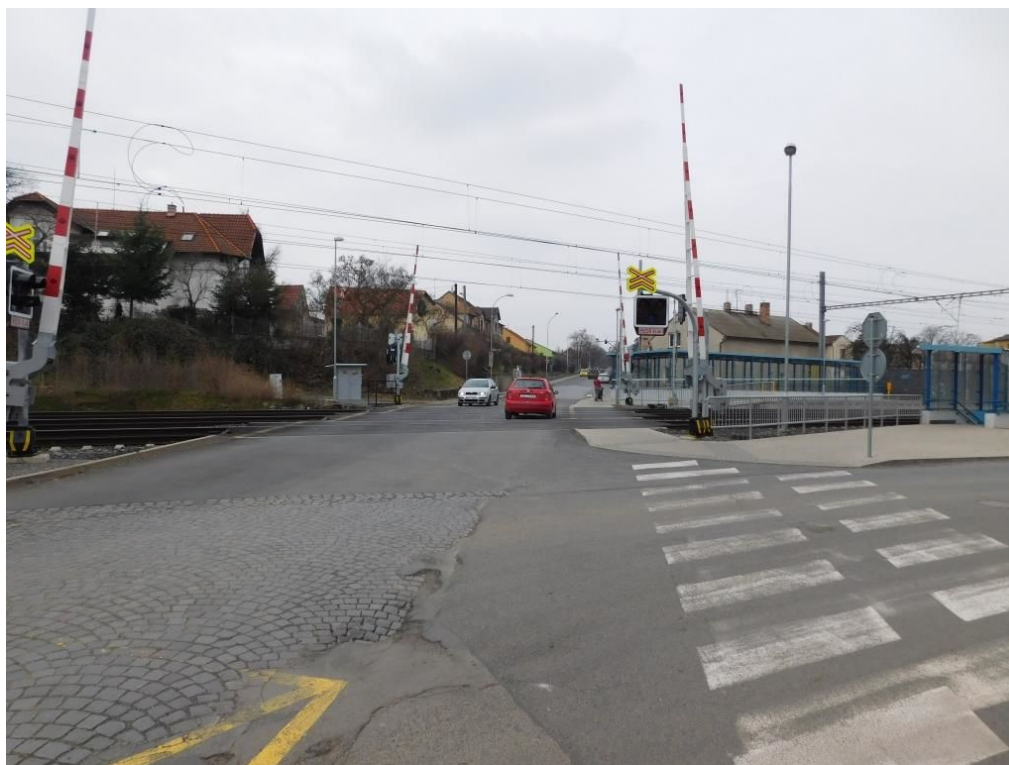
Přibližný záběr pevné kamery 5-1 směr -ulice Pražská a železniční přejezd
