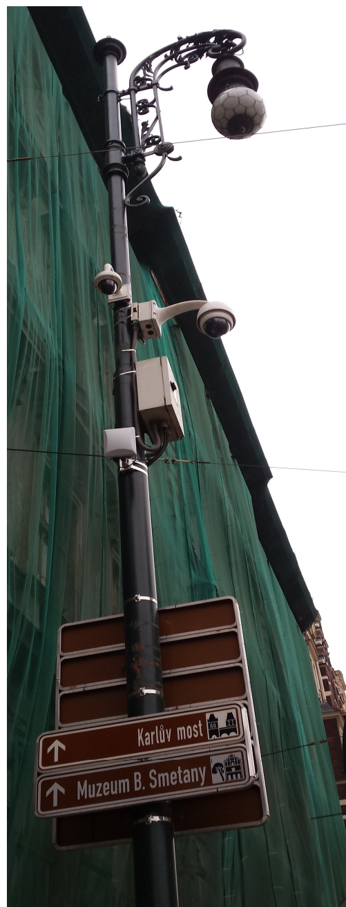
Příklady kamerových stání – vlevo na hraněném parkovém sloupu J8 s otočnou kamerou a mikrovlnným spojem , vpravo na historickém sloupu s otočnou kamerou typu autodome a pevnou kamerou typu minidome a se spojem WiFi
