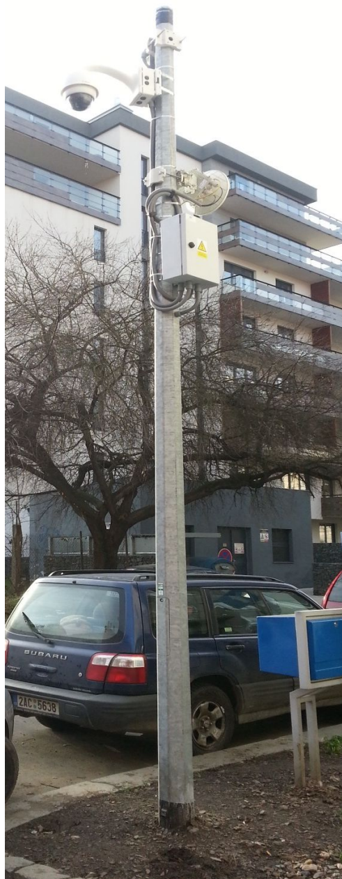
Příklady kamerových stání – vlevo na hraněném parkovém sloupu J8 s otočnou kamerou a mikrovlnným spojem , vpravo na historickém sloupu s otočnou kamerou typu autodome a pevnou kamerou typu minidome a se spojem WiFi
