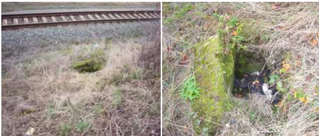
Obrázek 4: Šachta (ukončení) stoky N v drážním tělese
