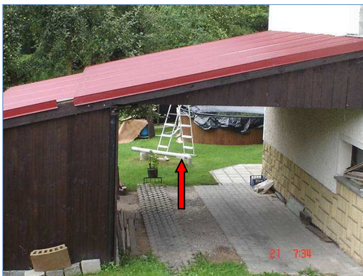
Obrázek 69: Havarijní odtok odpadní vody z ČK na trávník.
