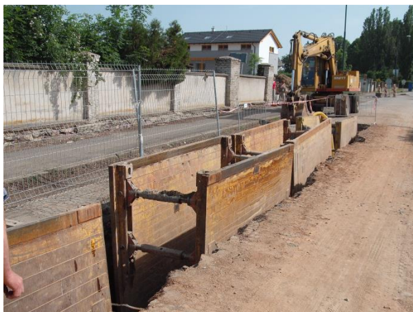
Obr. Výstavba kanalizace v ul. 5. května
