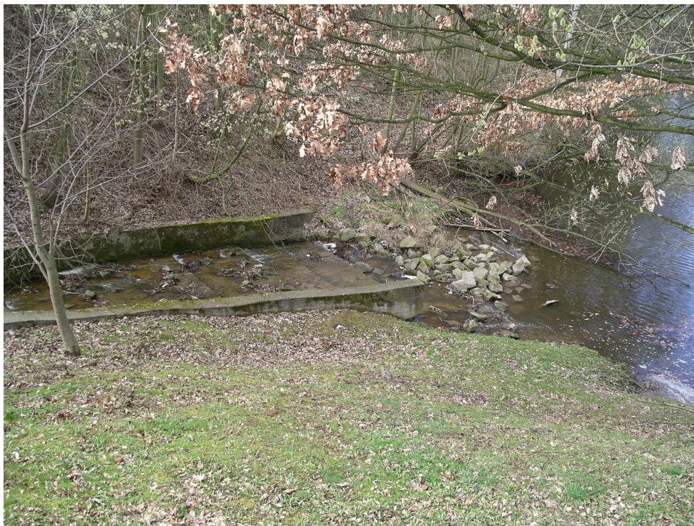
Foto č.5 – Ukončení skluzu. Dopadiště je nutné stabilizovat a opevnit.
