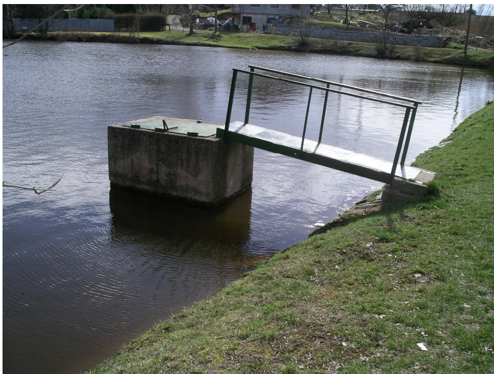
Foto č.2 – Stávající požerák – bude provedeno navýšení.
