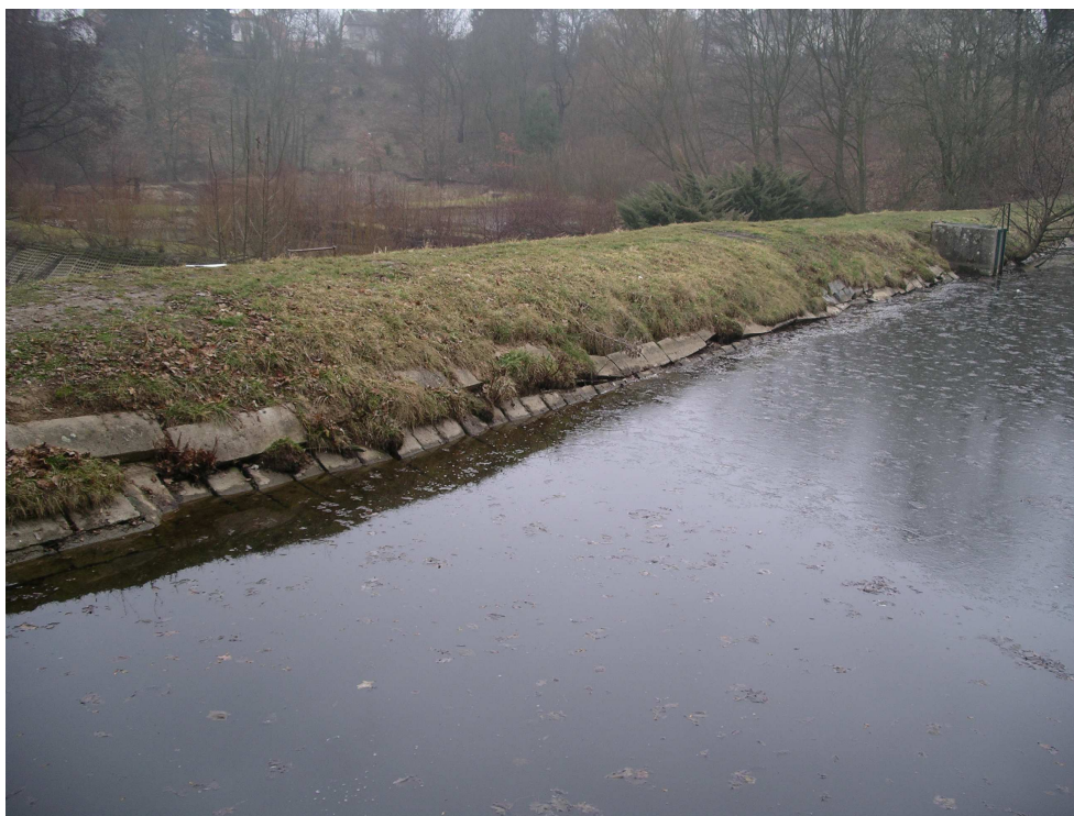
Foto č.3 – Pohled na opevnění návodního líce.
