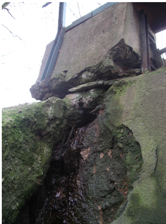
Foto č.6 a 7 – Detail bezpečnostního přelivu a spadiště. Stav konstrukce je havarijní.
