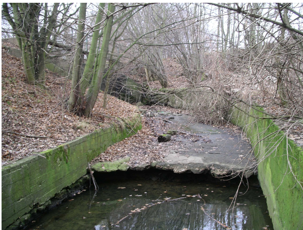
Foto č.8 – Odpadní koryto od bezpečnostního přelivu je taktéž v havarijním stavu.
