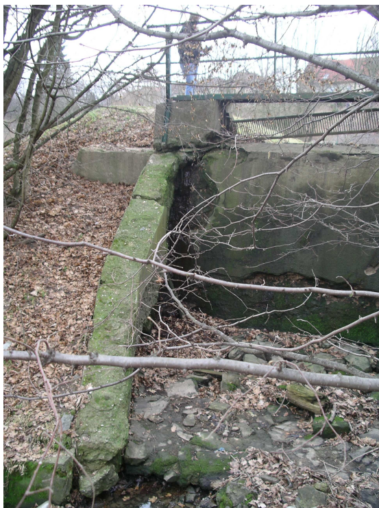
Foto č.6 a 7 – Detail bezpečnostního přelivu a spadiště. Stav konstrukce je havarijní.
