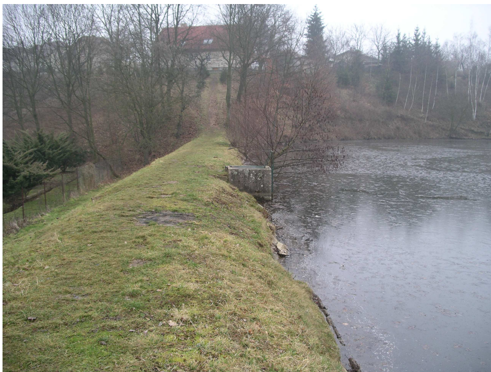
Foto č.2 - Pohled na hráz od bezpečnostního přelivu. Koruna má nedostatečné převýšení, opevnění návodního líce je porušené. V pozadí je vidět stezka vedoucí z koruny hráze po východním břehu rybníka.
