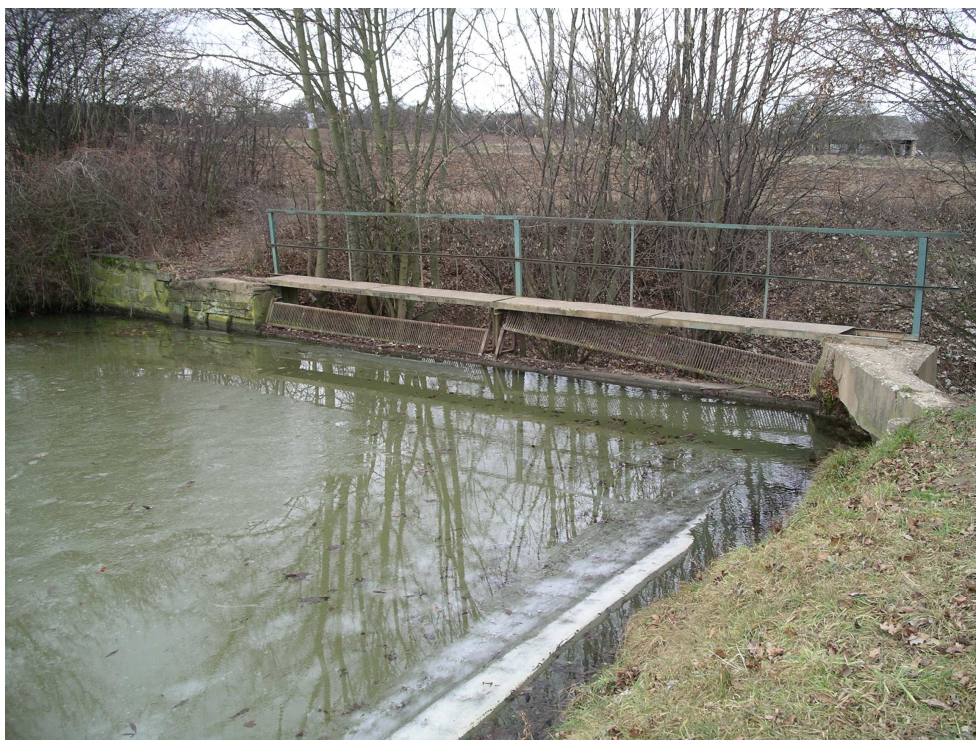
Foto č.5 – Bezpečnostní přeliv je nekapacitní a je ve špatném technickém stavu.
