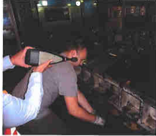
Měřicí místo M4: seřizování a výměna matic a nástrojů (linka odstavena - práce uvnitř opláštění)
