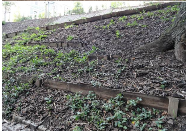
Inspirační ukázka stabilizace svahu a instalace dřevěných latí.
