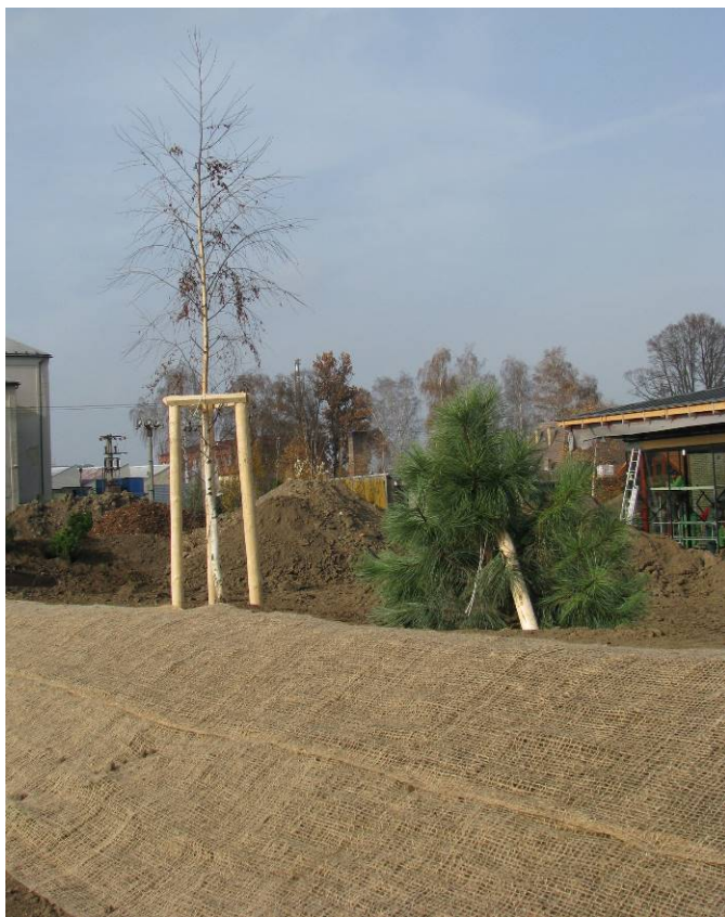
Inspirační ukázka stabilizace svahu a instalace dřevěných latí.
