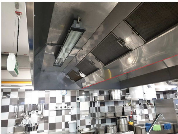
Obrázek 1 – Digestoř s vyznačenou hranou bez sběrné vaničky
