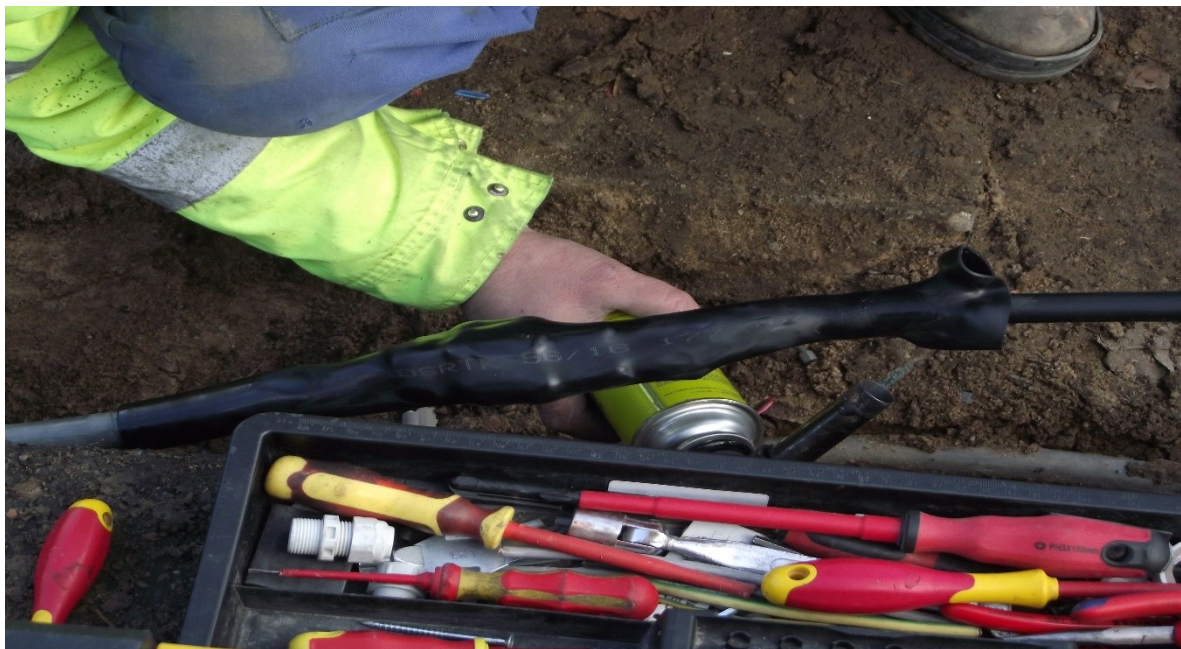
Obr. 2: Oprava VO Jeronýmova
