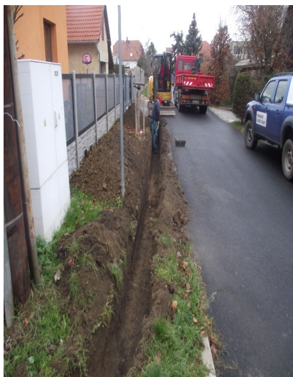
Obr. 1: Realizace VO – Slovinská
