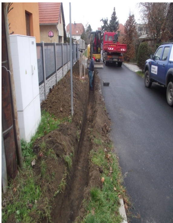
Obr. 1: Realizace VO – Slovinská
