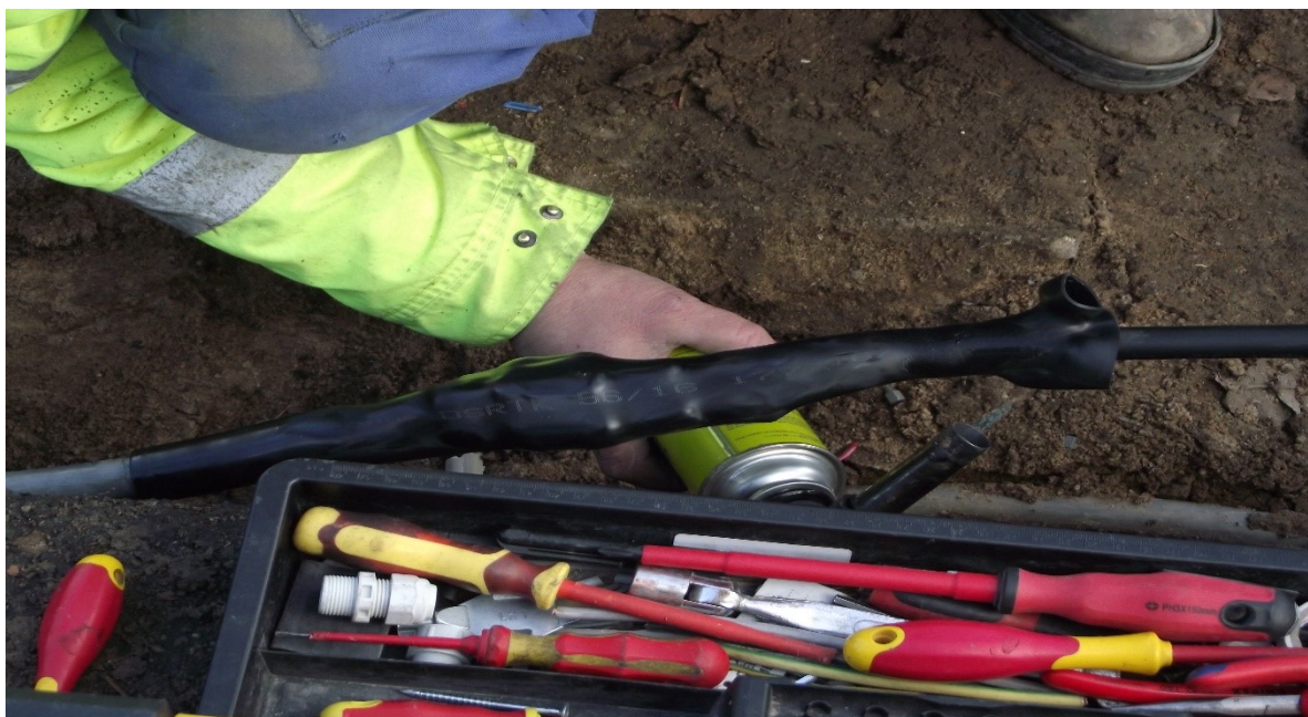
Obr. 2: Oprava VO Jeronýmova
