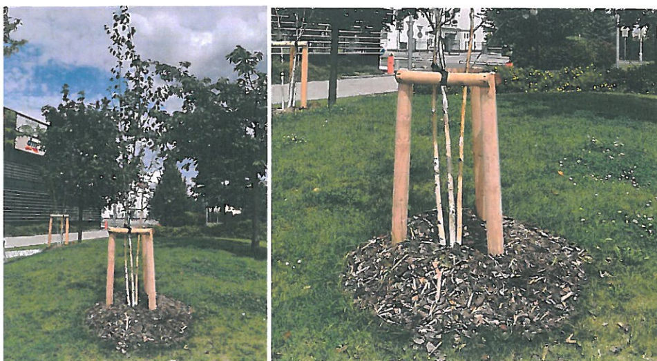
Ukázka kotvení kts (vícekmennů)
