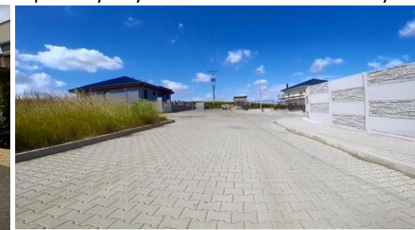
Obrázek 4 – povrch ze zámkové dlažby bez závad
