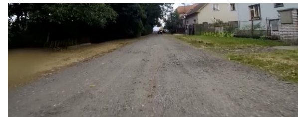
Obrázek 11 - nezpevněný povrch se stř. poruchami
