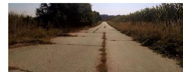
Obrázek 15 - panely s těžkými poruchami
