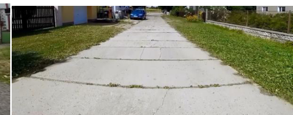
Obrázek 12 - panely se středními poruchami
