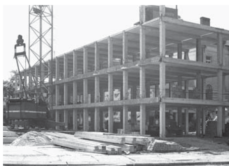
Přístavba základní školy v roce 1969
