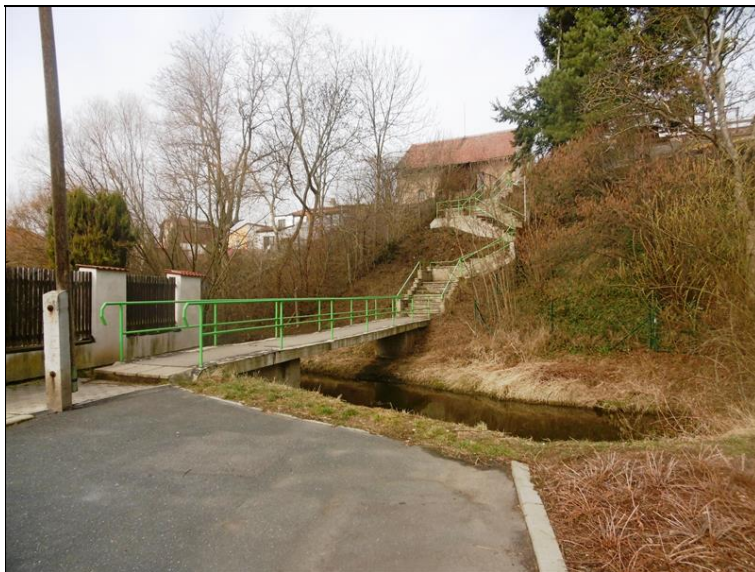
Pohled na lávku od ulice U Výmoly ( od jihu ).
