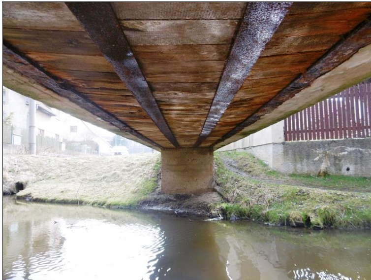
Podhled nosné konstrukce.
