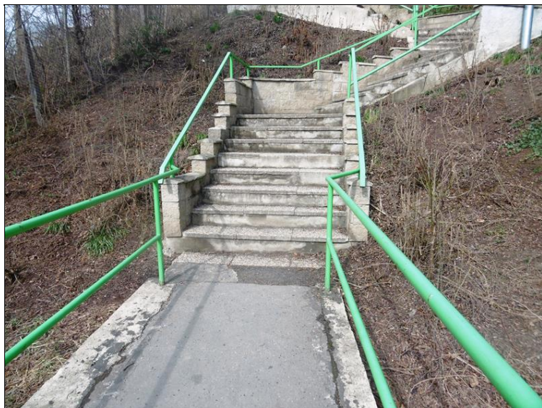
Pohled na schodiště na levém břehu ( severní strana).
