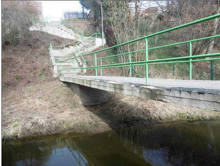
Pohled na lávku ve směru toku.
