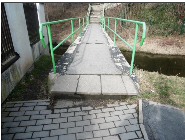
Pohled na lávku z jihu.
