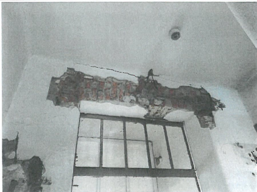
5-Částečná demolice nadokenního překladu
