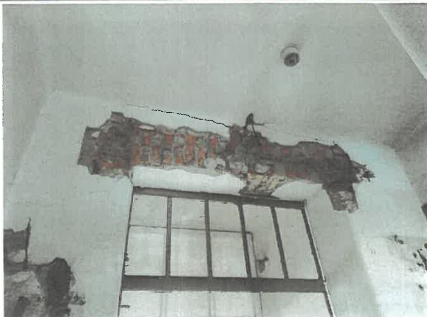
5-Částečná demolice nadokenního překladu
