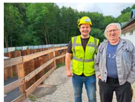
Pracovník ČOV Kolařík a stavbyvedoucí Palička
