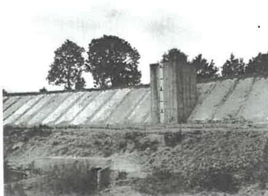
Pohled na hráz s požerákem z doby výstavby (zdroj – ČRS MO Úvaly)
