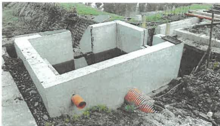
Rekonstrukce loviště, korugované potrubí DN 500 (říjen 2019)
