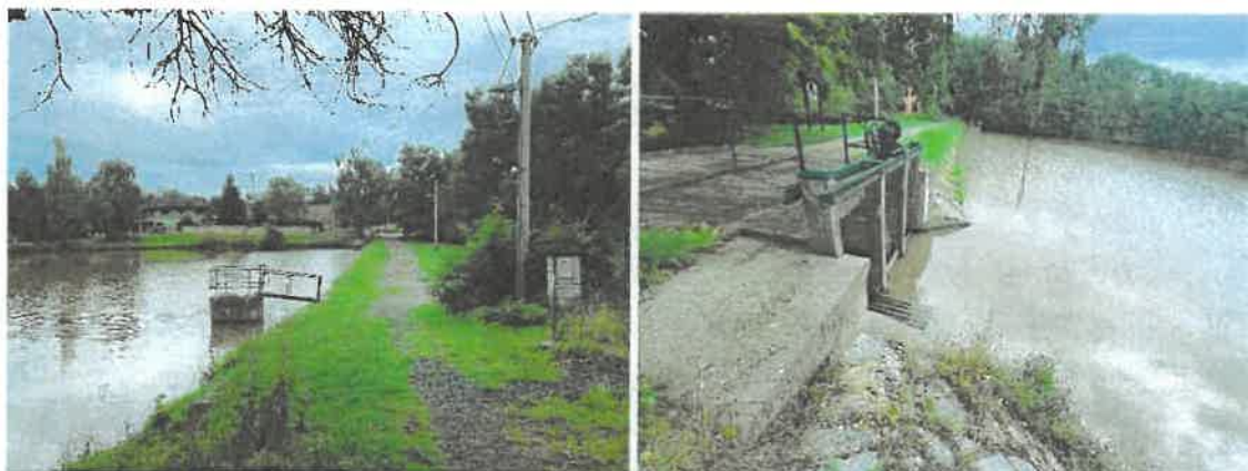
Pohled na hráz s požerákem, pohled na výpustný objekt - současný stav (2025)
