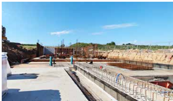
Stavba školy v srpnu 2026
