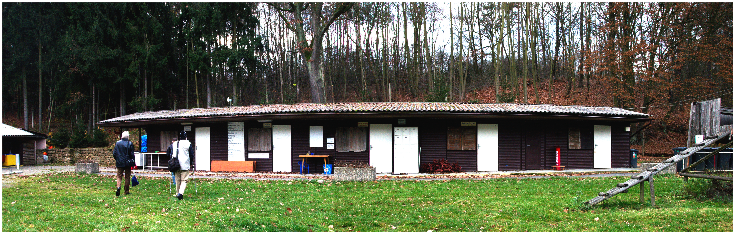
Pohled na provozní budovu od bazénu
