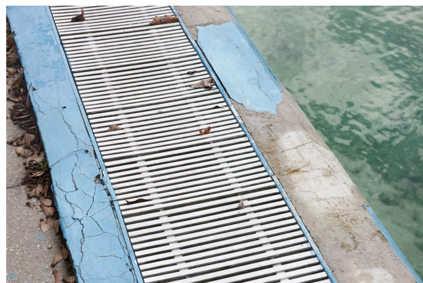
Popraskané hrany horní plochy žlábků
