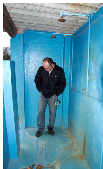
Vnitřní pohled do sprch
