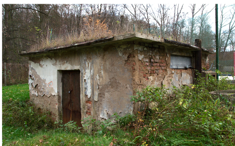
Pohled na objekt studny
