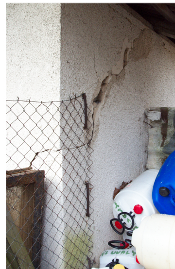
Popraskané stěny úpravny vody
