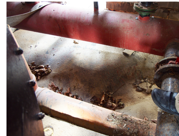
Vyboulená podlaha úpravny vody
