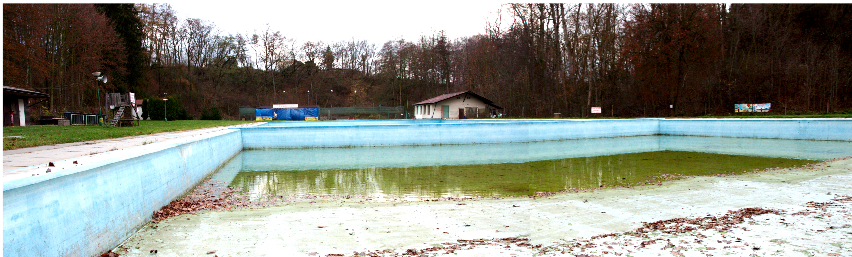
Pohled na menší bazén od vstupního schodiště
