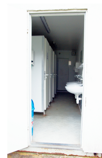
Vnitřek soc. zařízení
