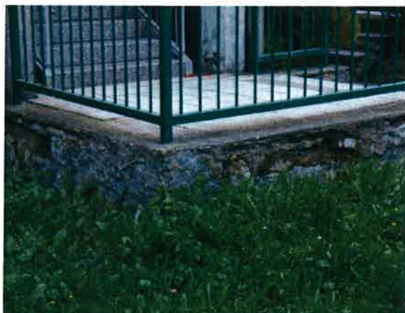
Jak je vidět, terasy se postupně rozpadají. Týká se to všech teras a schodišť do pavilónů školky.
