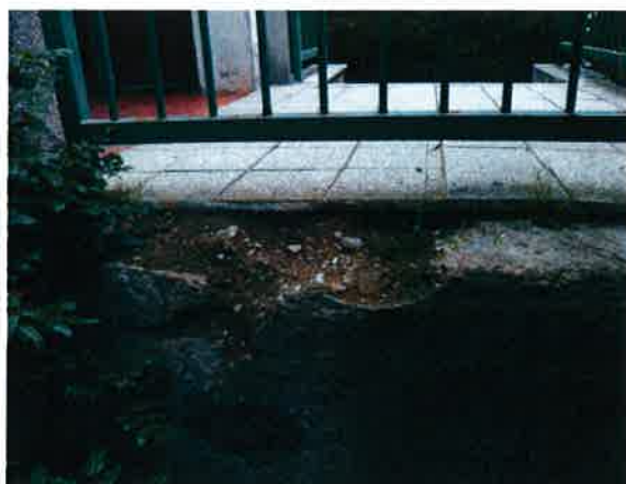
Jak je vidět, terasy se postupně rozpadají. Týká se to všech teras a schodišť do pavilónů školky.
