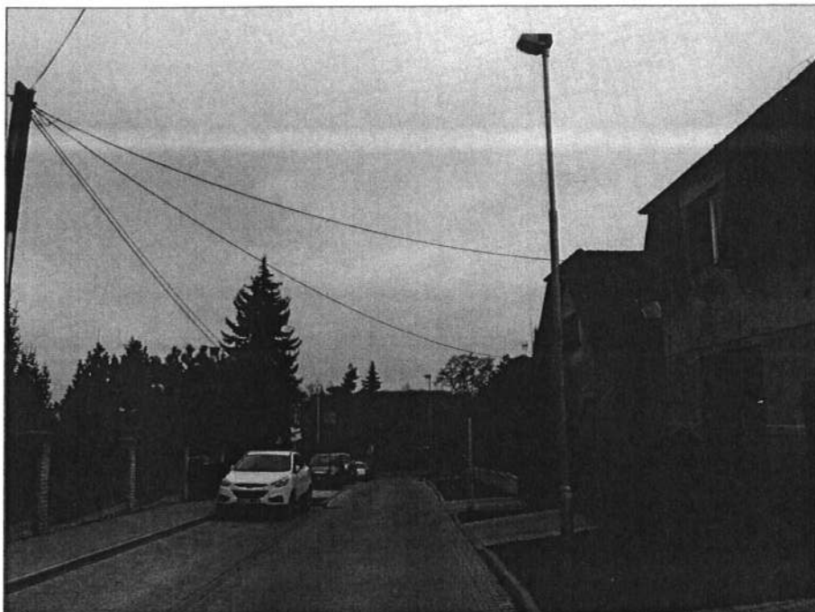
Rekonstrukce veřejného osvětlení ul. Kožíškova
