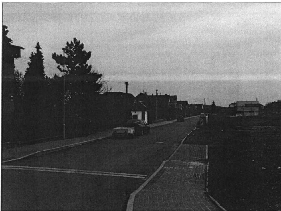
Rekonstrukce veřejného osvětlení ul. Palackého
